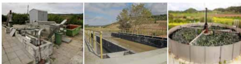
Figura 7 Obra de entrada (esquerda), Tanque Imhoff (centro) e Leito Percolador (direita) da ETAR de Óbidos
