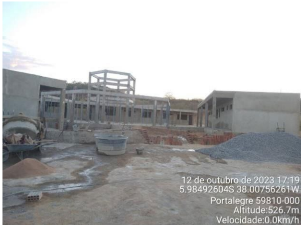
Figura 7 – Escola de Ensino Fundamental, em construção, na Comunidade Quilombola Sítio Arrojado
